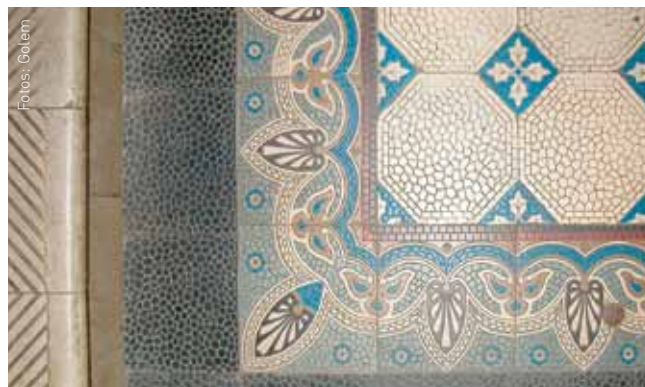
Diese Original-Steinzeugfliesen wurden in einem Berliner Baudenkmal gefunden.
