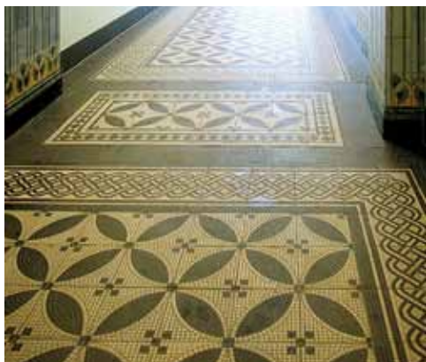
Original und Nachbildung: oben ein Hausflur mit Originalverlegung, unten ein Ausschnitt einer Replik mit dem selben Muster.
