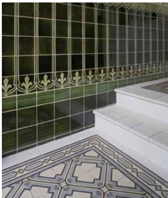
In diesem Hausflur wurden sowohl Wand- als auch Bodenfliesen originalgetreu rekonstruiert.
